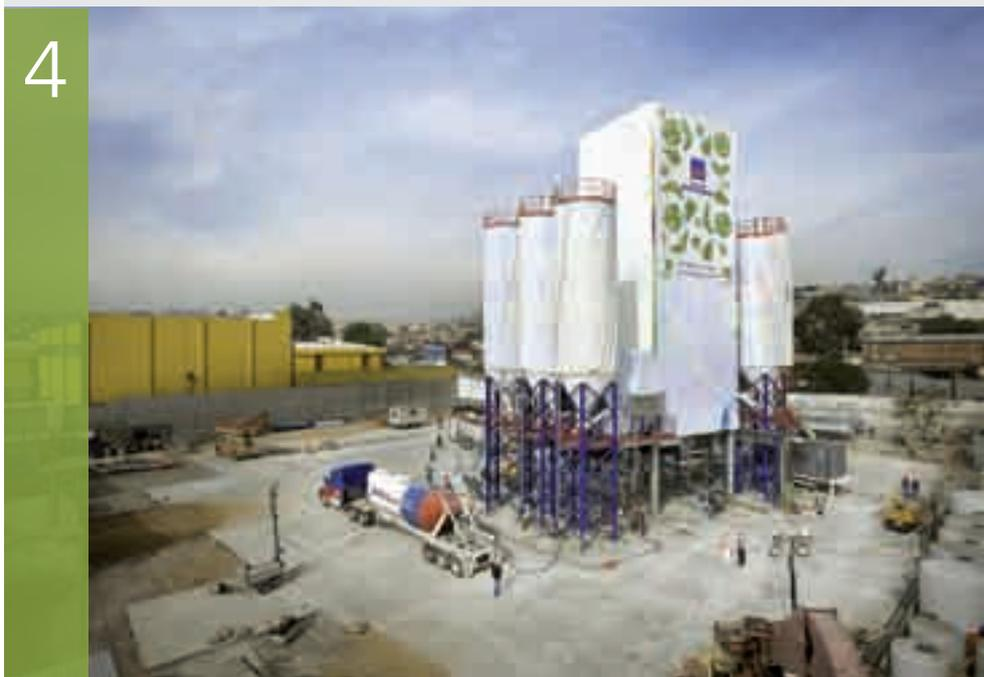
Il sistema degli additivi assicura l'approvvigionamento di 9 tipi differenti di materiali, consentendo la produzione di una vasta gamma di calcestruzzi.
